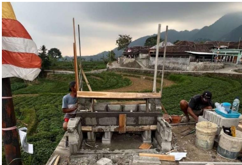
Gambar 3. Proses Pembuatan Rocket Stove Incinerator
